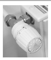
Un robinet thermostatique limite la température ambiante de la pièce en agissant sur le débit du fluide chauffant circulant dans le radiateur.
